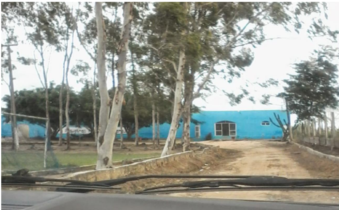
Foto 3 - o prédio do hospital. Acervo pessoal da autora.
