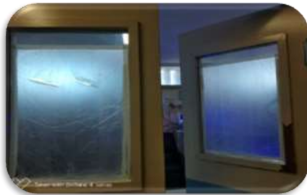
Figura 25 – Não temos cortinas, mas improvisamos um bloqueio da visão.
