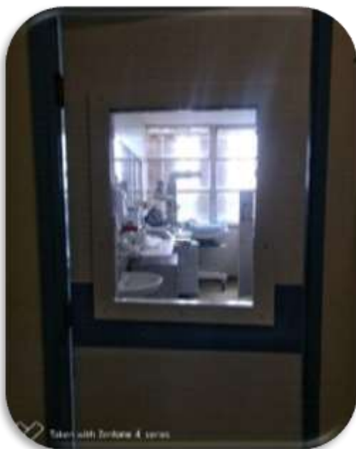
Figura 27 – Encontramos uma janela sem obstrução da visão.
