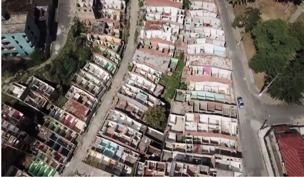
Figura 7: Casas e prédios em ruínas.
