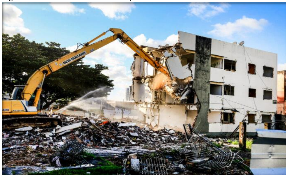
Figura 19: Retroescavadeira demolindo prédio residencial no bairro do Pinheiro.
